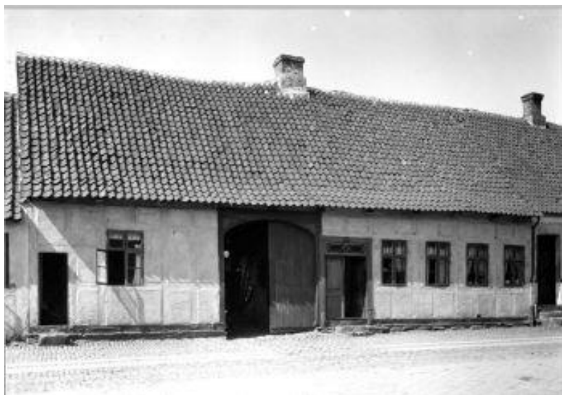
Dronningensgade 54. Avlsbruger Devantiers ejendom ca. 1904. Bag døren og vinduet til venstre findes soldaterkammeret. (Foto LAFO)
